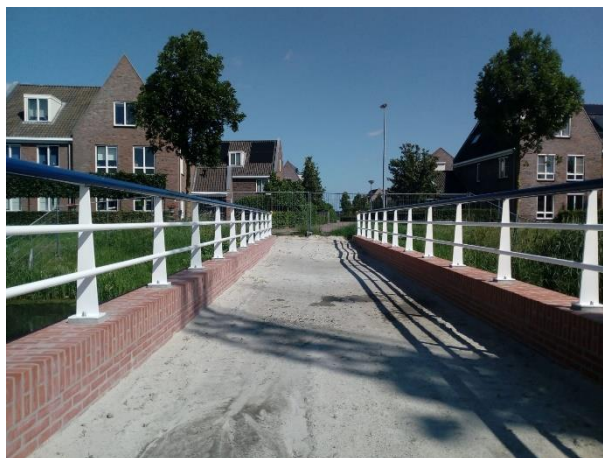
Foto 2 Brug vanaf Reitdiep naar Kleiwerd
